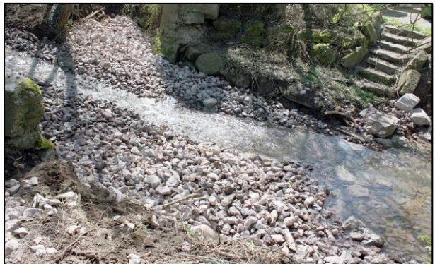
Gut zu erkennen: Die Strömungsabschnitte. Bereits am zweiten Tag ist die Fischpassage fertig.
