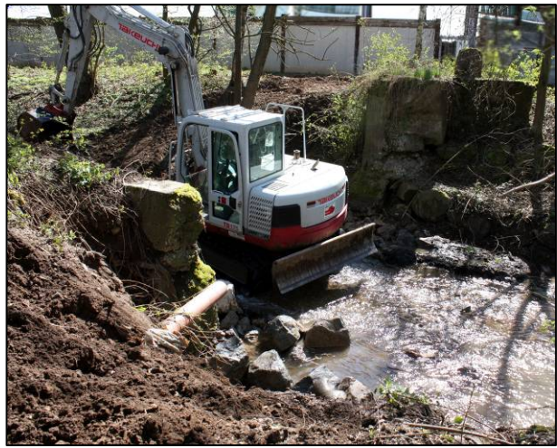
Mit schwerem Gerät muss das Betonfundament aus dem Bachbett gegraben werden.
